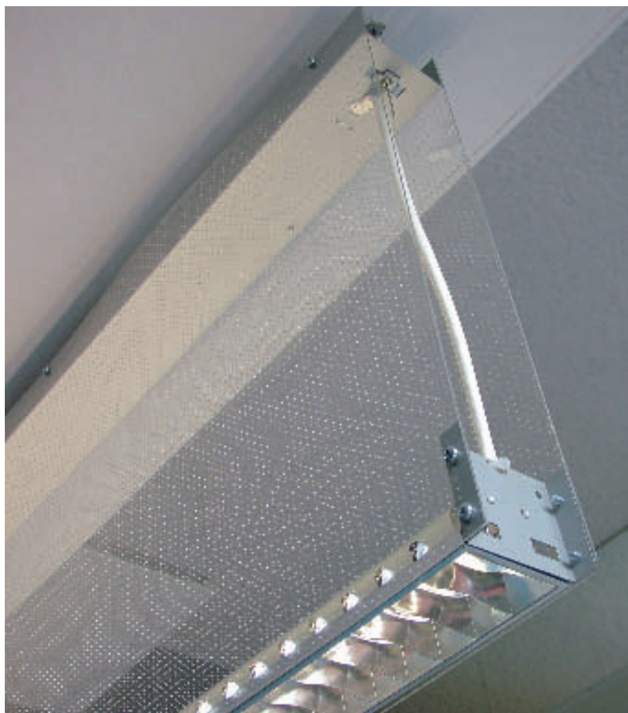
Verlichtingsarmatuur met geluidsabsorberende beplating, ontwerp Rudy Uytenhaak.
